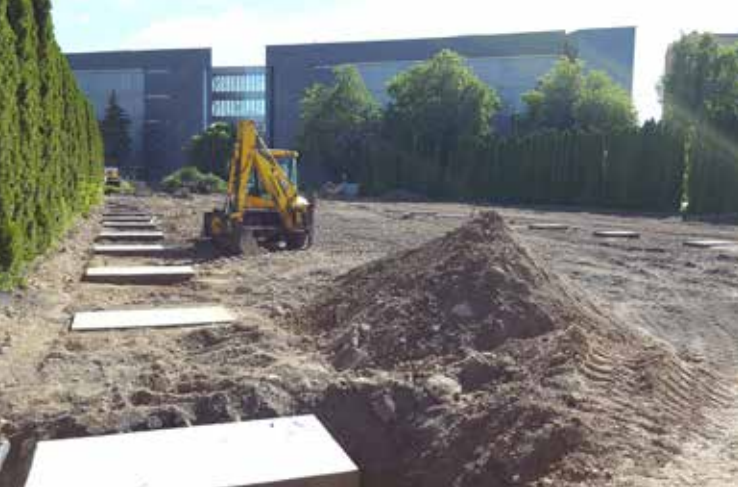
Przygotowanie terenu pod nowe obiekty, zlokalizowane obok hali sportowej i naprzeciwko widocznych na zdjęciu budynków Biotechnologii i ICBN (fot. Piotr Olejarnik)
