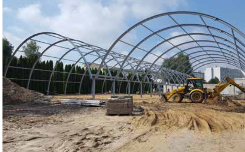
Konstrukcje szkieletowe nowych hal sportowych (fot. Piotr Olejarnik)
